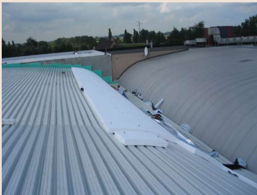
Er werd gebruik gemaakt van speciaal voorgevormde EPS platen die de kromming van het dak precies volgen.
