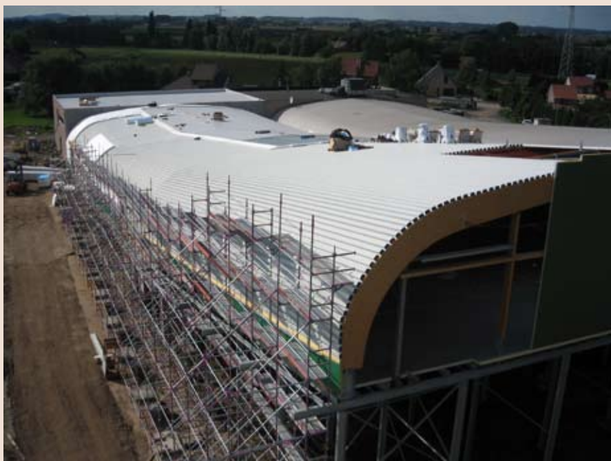
De speciale stellingen met uitkragende platformen maakten het werk aan dit speciale dak een stuk makkelijker
